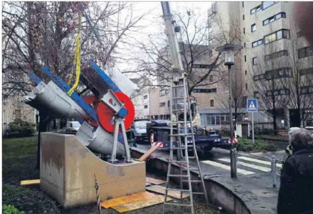
Mit einem Kran wurde das Denkmal auf den Betonsockel gesetzt. Offiziell eingeweiht werden soll es am 18. Februar. (Foto: Kirfel)
