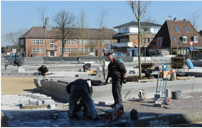
Arbeiter schneiden am Helmut-Loose-Platz die Granitplatten zu und verlegen sie auf der zentralen Platzfläche. FOTOS: ZIEHM
