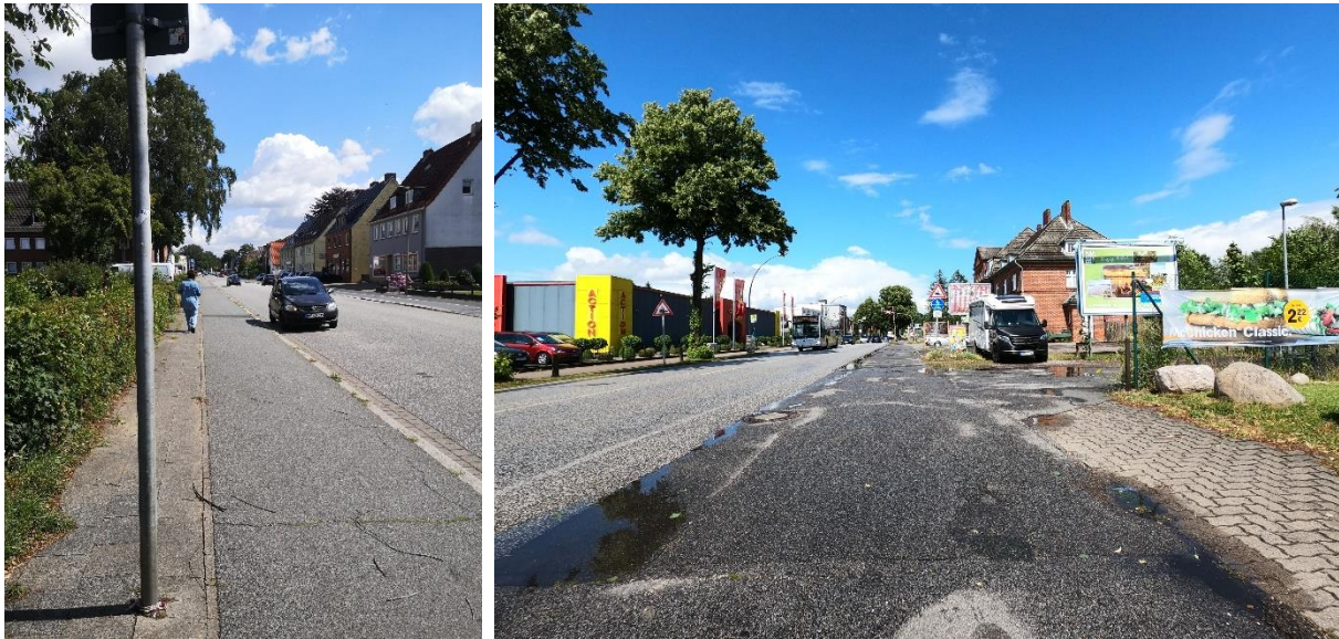
Abbildung 5: Schmäler Gehweg entlang der Ehndorfer Straße (links) und fehlende Markierungen entlang der Altonaer Straße (rechts)
