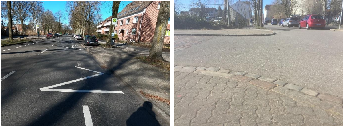
Abbildung 10: fehlende taktile Elemente an der Bushaltestelle "Carlstraße" (links) und fehlende abgesenkte Bordsteine an der Kreuzung Bismarckstr./ Vicelinstr. (rechts)
