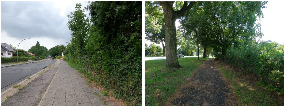
Abbildung 4: Getrennter Geh- und Radweg entlang der Padenstedter Landstraße (links) und gemeinsamer Geh- und Radweg entlang der Altonaer Str. (rechts)
